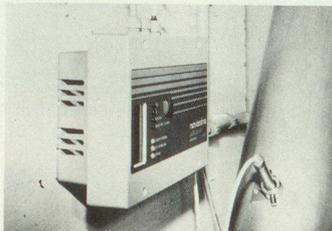
*Feuchte- und Temperatur-Messanlage für Raumklima. Der Anschluss von bis 32 Messstellen ist möglich.*
