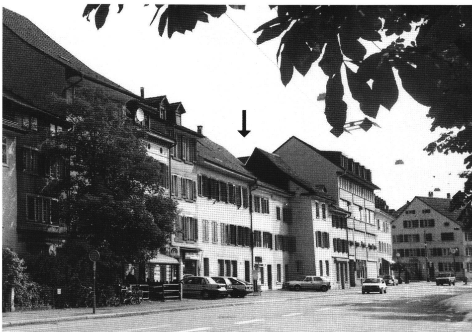
Abb. 1 Blick von Südwesten auf die Gebäude. Die Technikumstrasse erstreckt sich auf dem aufgeschütteten Stadtgraben. Die heutigen Hausfassaden entsprechen dem Verlauf der Stadtmauer. Die vorspringenden Häuser Technikumstrasse 18/20 geben eine gute Vorstellung des Bauvolumens des Befestigungsturms. Der Pfeil weist auf die Technikumsstrasse 22.
