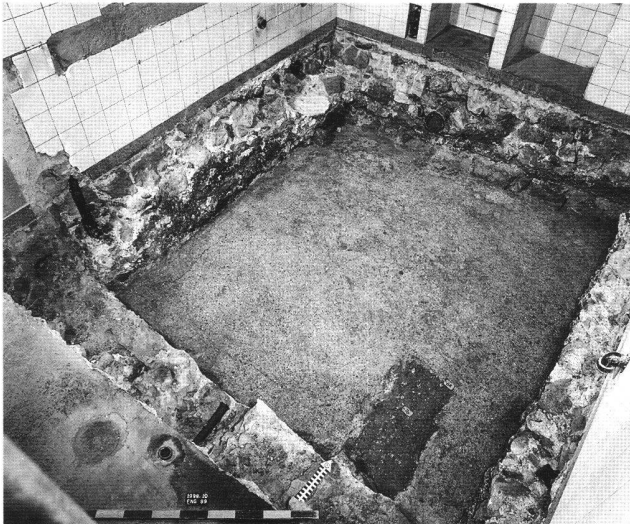
Abb. 7 Ansicht des Mörtelbodens im Turm (Steinbau A). Von den Turmmauern sind nur noch geringe Reste vorhanden, auf welche jüngere Mauern fundiert wurden. Auf diese Weise überdauerte der Grundriss des Turms im heutigen Innenraum. Im Vordergrund des Mörtelbodens befindet sich die Aussparung, in welcher möglicherweise der Sockel einer Innentreppe stand. Der Eingang in den Turm befand sich in einem der oberen Stockwerke.
