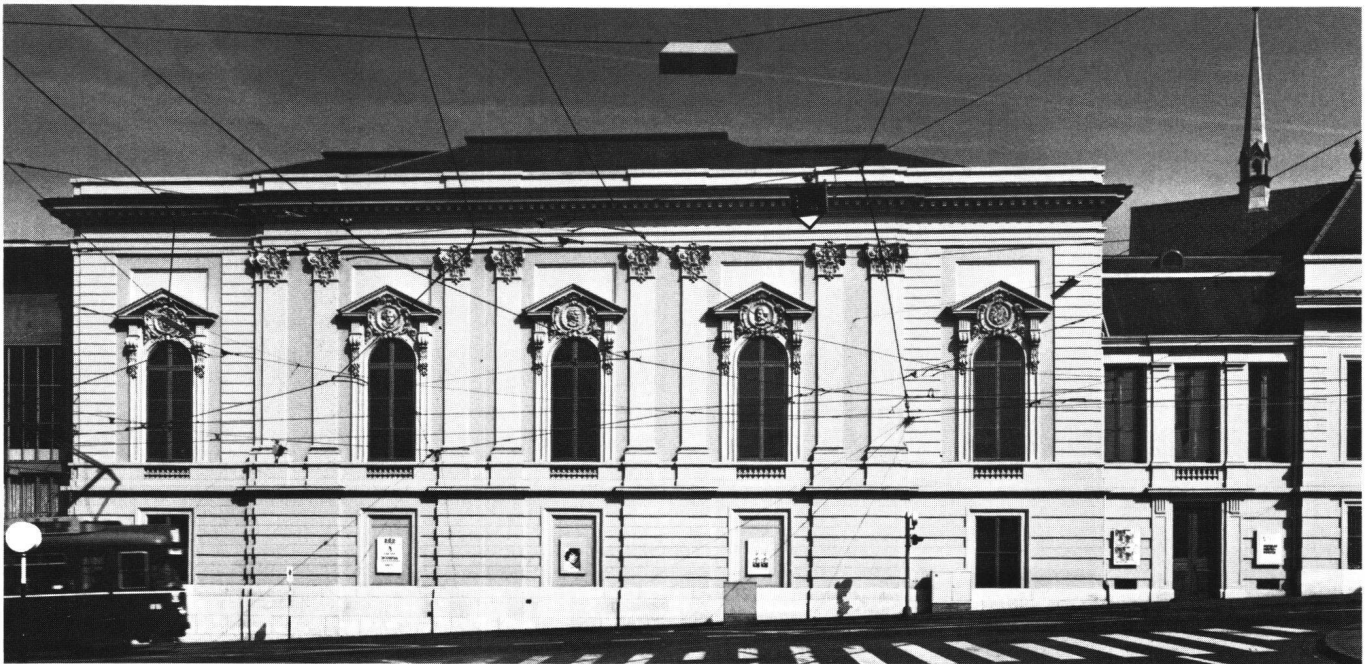
Abb. 21 Hauptfassade des Musiksaals in Basel nach der Renovation von 1979.
