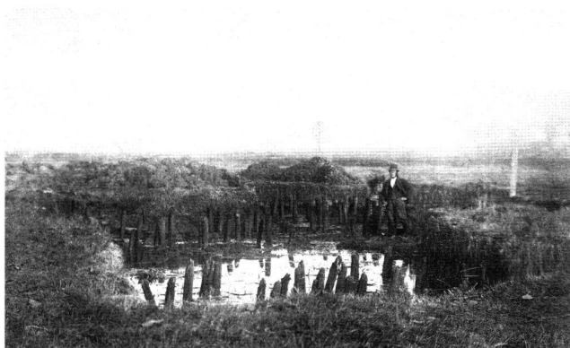
Abb. 2 Jakob Messikommer bei der Ausgrabung eines «Schachtes» mit deutlich sichtbaren Pfahlsetzungen. Von Westen. Aufnahme vom Dezember 1884.
