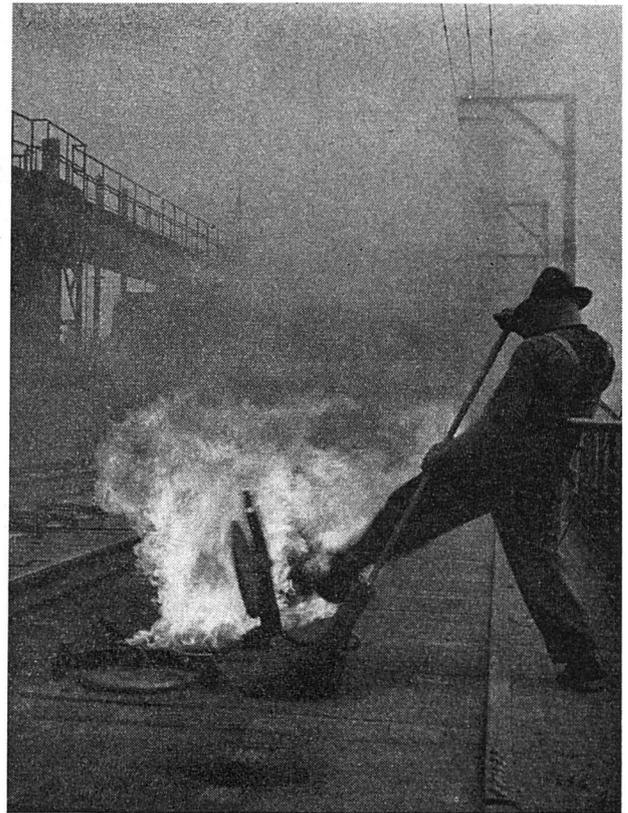
▲ Eine Aufnahme im Gaswerk Schlieren, Zürich. Der Ofenarbeiter des Gaswerkes schließt die soeben mit Rohkohle eingefüllte Kammer.
