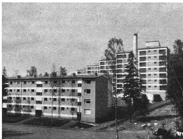
Wohnhäuser und Heizzentrale in der Gartenstadt Tapiola
