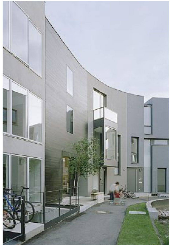
Zur Erschliessungsgasse hat das Haus nur eine Breite von knappen 5 Metern, öffnet sich aber zum Garten hin auf über 8 Meter. – Bild: Werner Huthmacher
