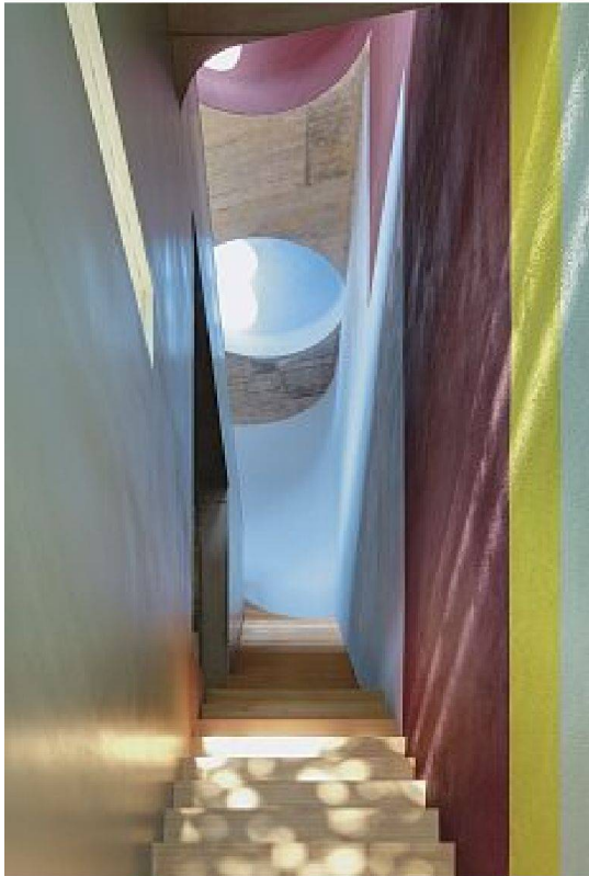
Oben: Die einläufige Treppe wird von der tragenden Wandschotte begleitet und verbindet, mit wohltemperierter Farbigkeit und dramatischer Lichtführung durch die Kugelalotten in der Dachhaut, die Wohngeschosse. – Bild: Jan Bitter
