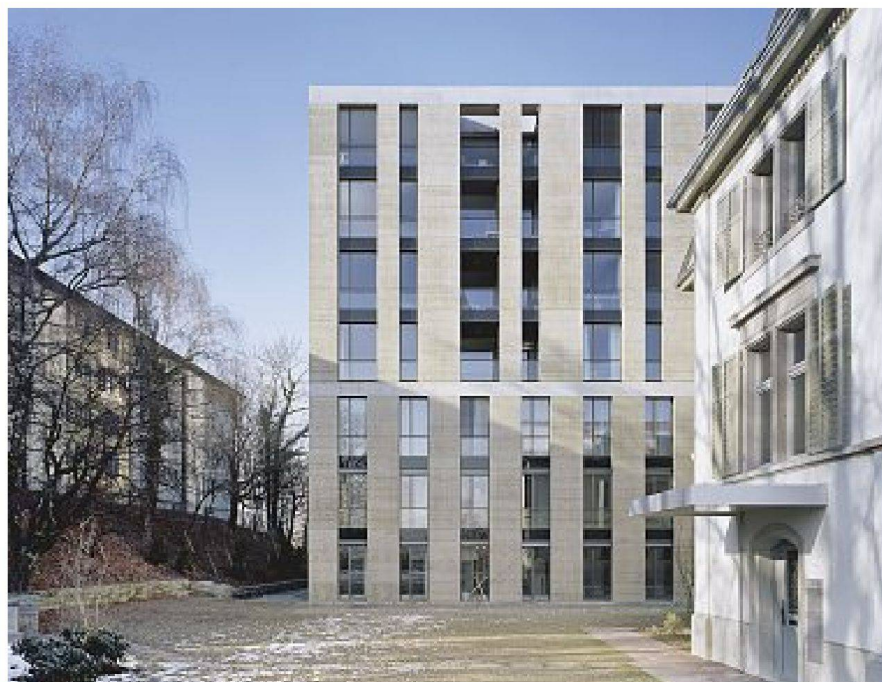
Wohngebäude Malzturm, rechts das Braumeisterhaus
