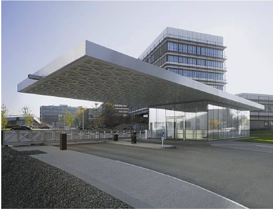
oben: Zwanzig-Meter-Auskragung des Stahldachs über dem Pfortnerhaus unten: Das lasergeschnittene Ornament an der Unterseite zeigt den Kräfteverlauf im Dach. – Bilder: Zoëy Braun
