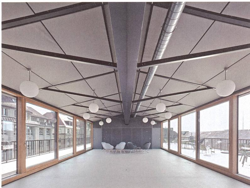
Den ebenfalls stützenfreien Aufenthaltsraum im Dachgeschoss überspannt ein fast 40 Meter langer Stahlträger in Längsrichtung (Bild oben). In den Bürogeschossen ordnen sich auch die Sitzungszimmer der Primärstruktur unter und stehen wie Möbel mit Luft zur Decke im Raum (unten).
