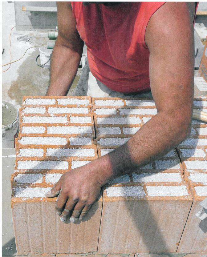
Die Baustelle lässt den Cluster-Grundriss mit Satellitenwohnungen und den versteifenden Kern in der Mitte erkennen (Bild oben: Johannes Marfurt). Quer versetztes Einsteinsmauerwerk mit Perlitfüllung (Bild: Katinka Cortis)
