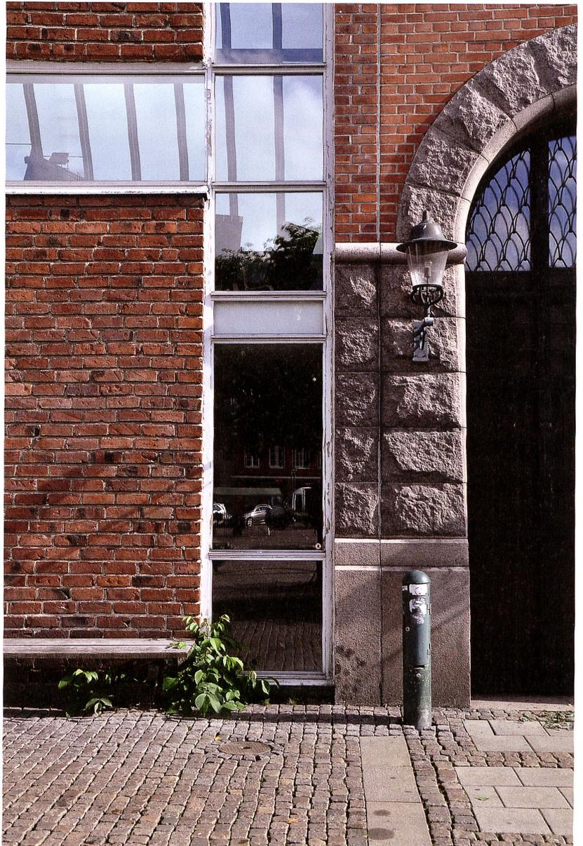
Städtebauliche Kontinuität im Detail: Beim Anschluss an das Nachbargebäude übernimmt Anshelm auf einer kurzen Strecke die Sprache des Altbaus, um erst dann mit einem Fensterschlitz die Zäsur deutlich zu machen.
