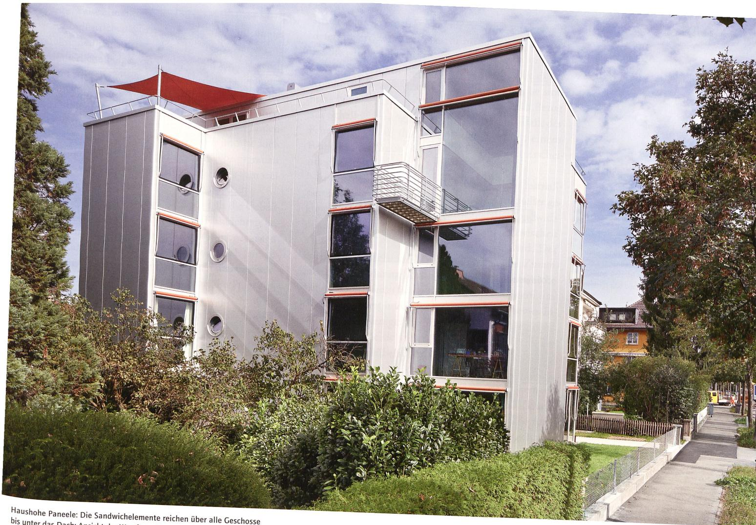
Haushohe Paneele: Die Sandwichelemente reichen über alle Geschosse bis unter das Dach; Ansicht der Westfassade, deren Fenster Blicke in die Tiefe der Regensbergstrasse erlauben (oben) und die relativ geschlossene, schmale Strassenfassade (unten)
