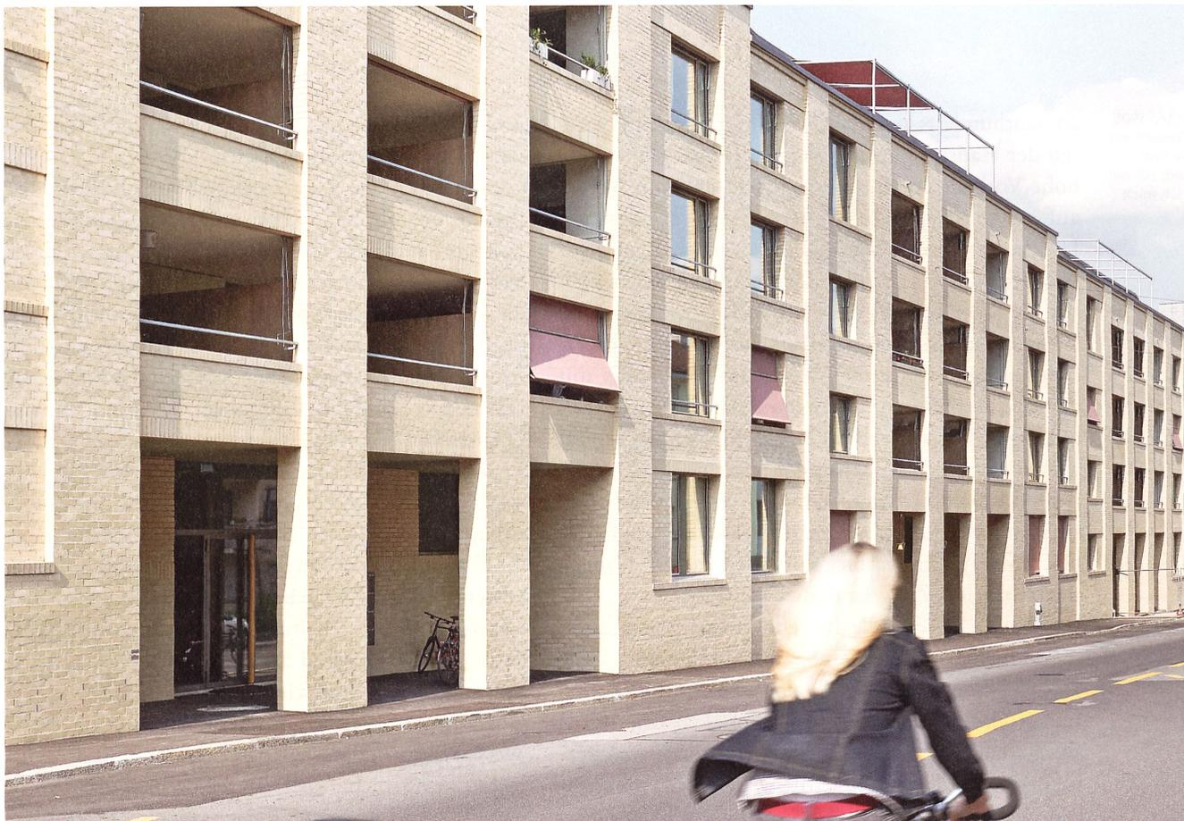
An der Schwarztorstrasse werden die sandfarbenen Klinkersteine so richtig spürbar; Lisenen und Rollschichten ordnen die Fassade, Nischen im Erdgeschoss markieren die Hauseingänge.
