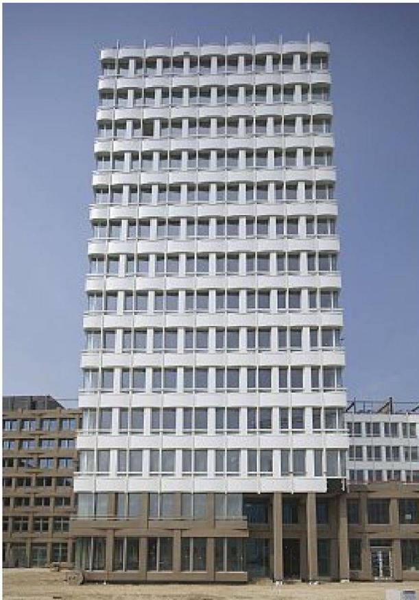
Agfa-Hochhaus, Metallfassade aus pulverbeschichtetem Aluminiumblech
