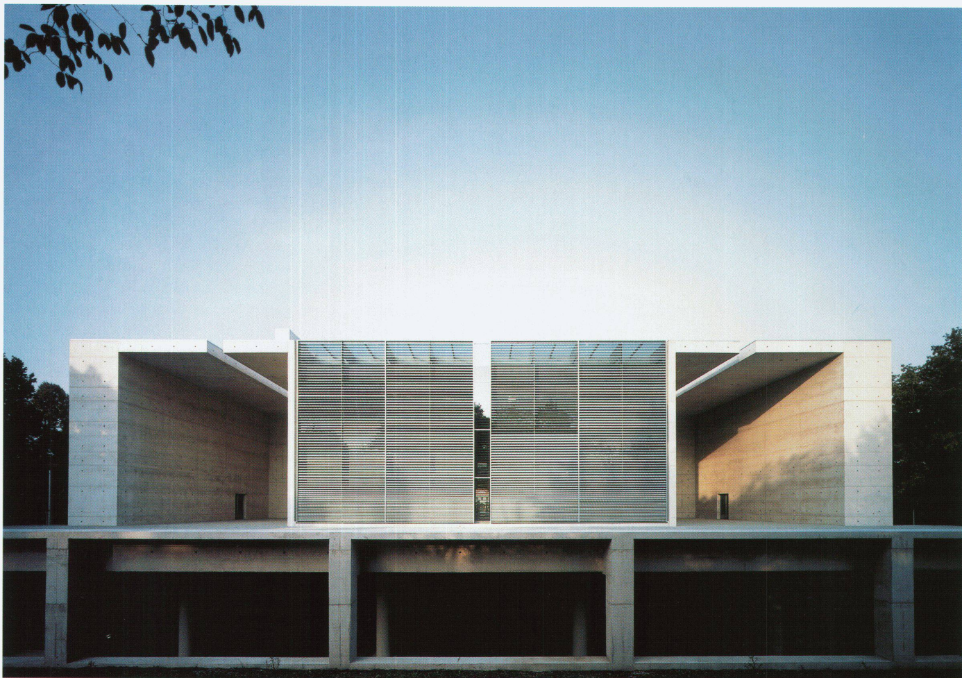
Rückfassade mit Anlieferung
