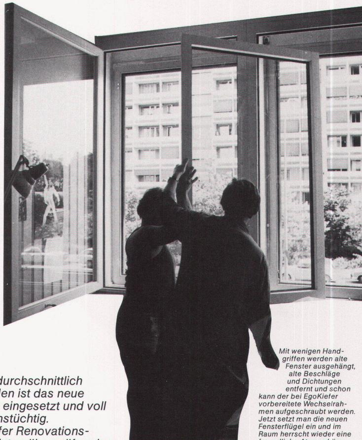
Mit wenigen Handgriffen werden alte Fenster ausgehängt, alte Beschläge und Dichtungen entfernt und schon kann der bei EgoKiefer vorbereitete Wechselrahmen aufgeschraubt werden. Jetzt setzt man die neuen Fensterflügel ein und im Raum herrscht wieder eine freundliche Atmosphäre, ohne dass es zieht.
