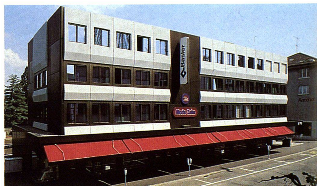
Geschäftshaus, CH-Thalwil, 1976 INFRASTOP-Auresin 39/28 Arch. G. Theiler, Thalwil
