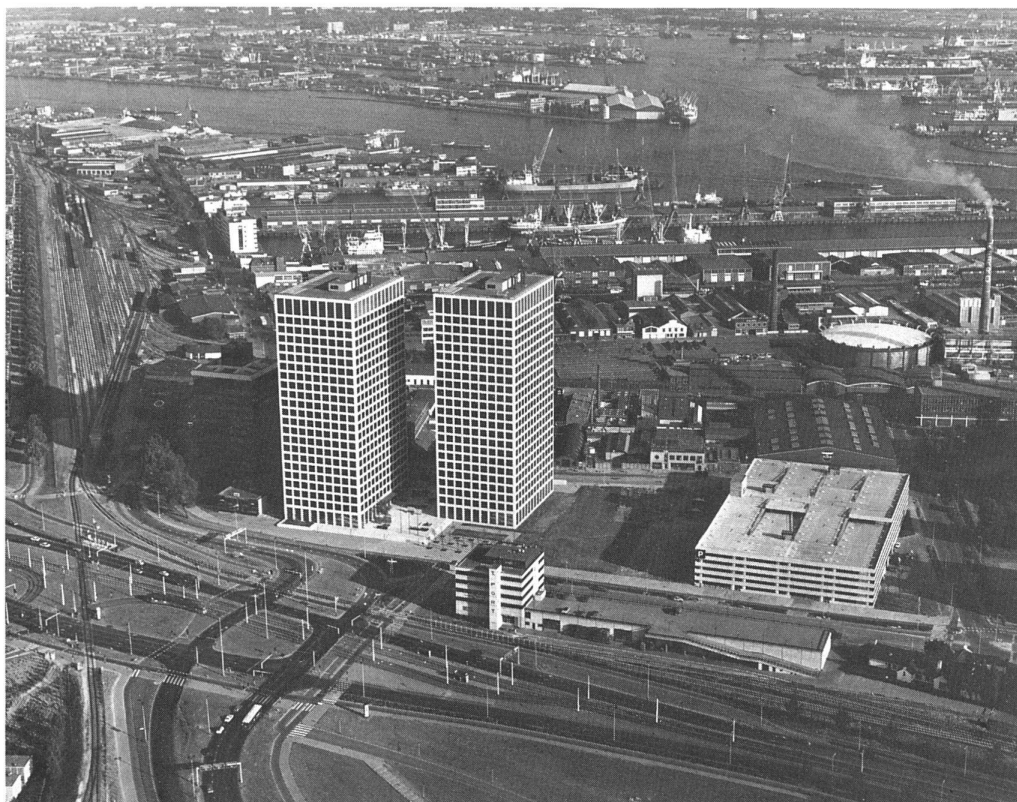
15 Skidmore, Owings and Merrill: Bürohochhäuser/immeubles de bureaux Europoint, Rotterdam (1975).
