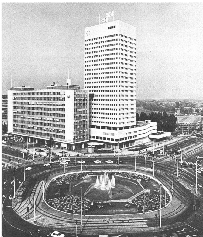
1 Shell-Gebäude in Rotterdam/bâtiments Shell à Rotterdam. Shell 1: scheibenförmiges Bürohaus im Sinne des 2. Basisplans/immeuble de bureaux comme bâtiment-barre selon le 2ème plan de base (Architekt/architecte: C.A. Abspoel, 1962). Shell 2: Büroturm im Massstab der Stadtregion/immeuble tour à l'échelle de la région urbaine (Architekten/architectes: Zanastra, de Clerqu Zubli, Lammertsma, 1974)
