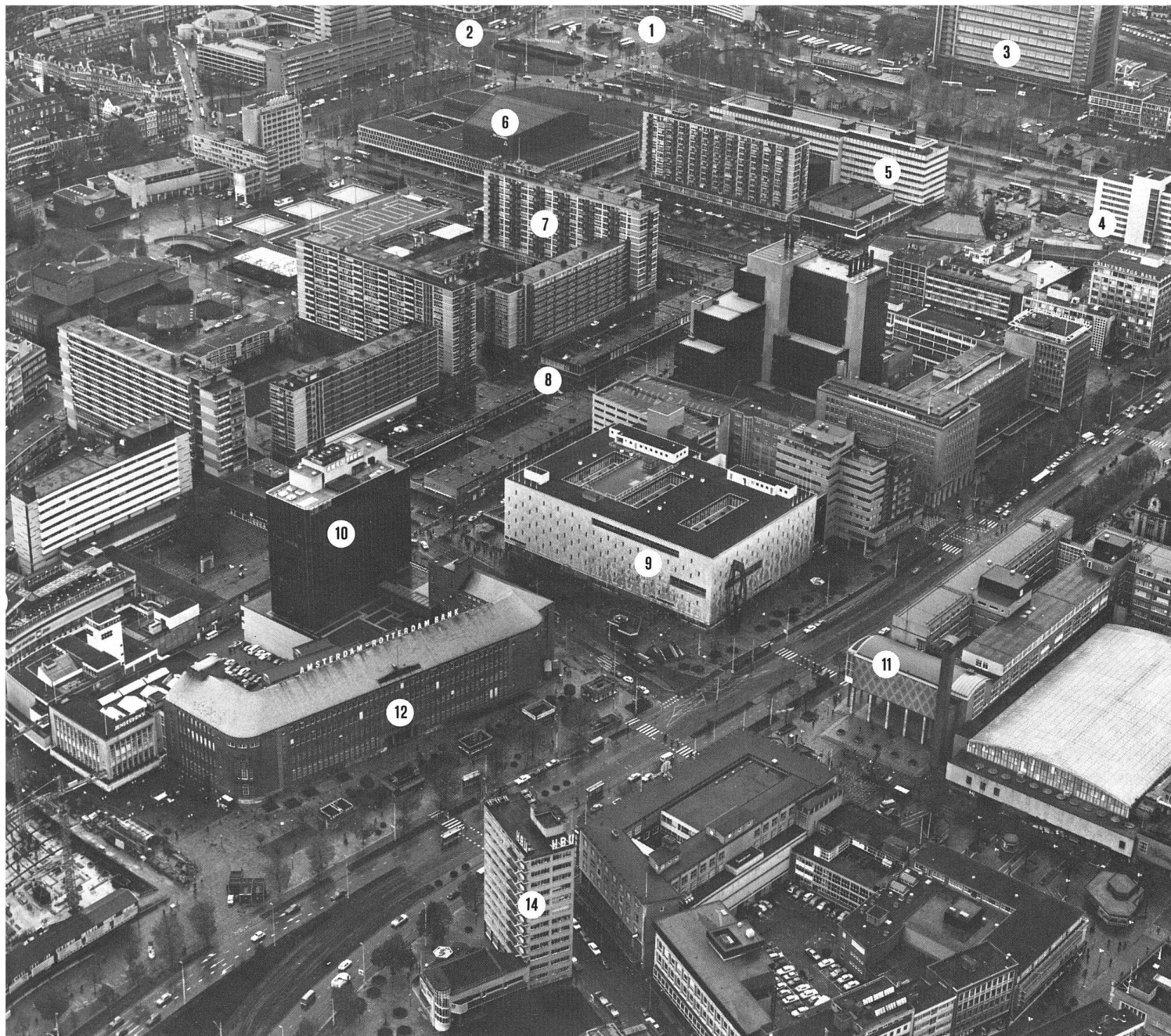
5 Das Zentrum von Rotterdam/le centre de Rotterdam (Luftaufnahme/vue aérienne). 1. Bahnhof/gare (1957); 2. Groothandelsgebouw (1951); 3. Bahnpost/PTT (1959); 4. Hilton-Hotel; 5. Texaco-Gebäude/immeuble Texaco; 6. Konzertgebäude "de Doelen"/salle de concert "de Doelen" (1966); 7. Lijnbaanflats (1956); 8. Lijnbaan-Ladenstrasse/rue marchande Lijnbaan (1953); 9. Warenhaus/grand magasin De Bijenkorf (M. Breuer, 1957); 10. Amro-Bank (1976); 11. Börse/bourse (J. F. Staal, 1939); 12. Amro-Bank (altes Gebäude/bâtiment ancien, vor/devant 1946); 13. Warenhaus/grand magasin Ter Meulen (1951); 14. Erasmushuis (W. M. Dudok, 1939).
