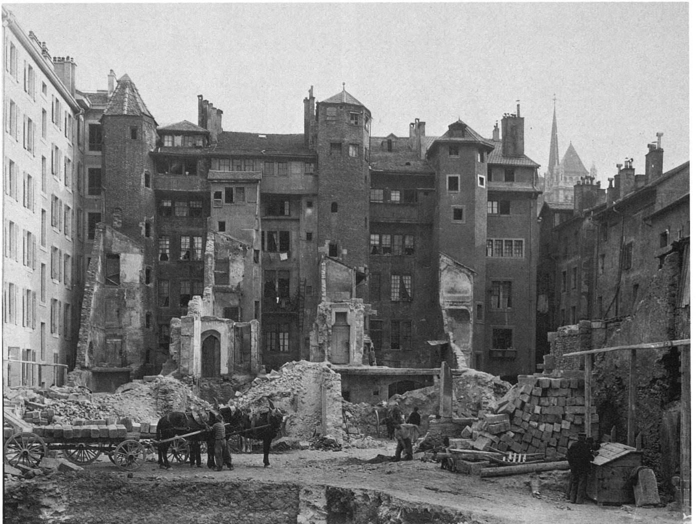
1 Abbruch von Altbauten im Quartier de Rive im Zusammenhang mit dem Strassendurchbruch der Rue de la Tour-Maitresse (um 1897) / Démolition des anciennes maisons du quartier de Rive pour percer la rue de la Tour-Maitresse (vers 1897). Oben rechts die Kathedrale Saint-Pierre; der Backsteinturm links gehört zum mittelalterlichen Palast des Bischofs von Nizza. / En haut à droite l'église Saint-Pierre. La tourelle en brique à gauche faisait partie du palais de l'Evêque de Nice.
