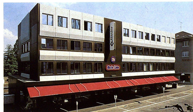
Geschäftshaus, CH-Thalwil, 1976 INFRASTOP-Auresin 39/28 Arch. G. Theiler, Thalwil
