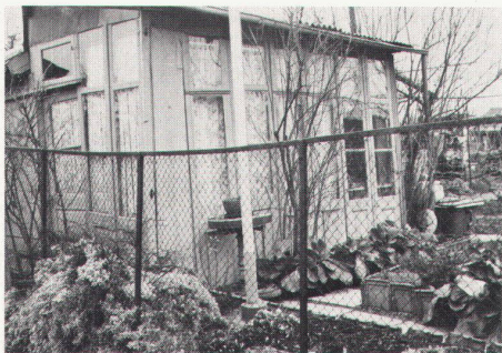
3 Spontane Architektur am Stadtrand: ein Haus, das aus Fenstern besteht
