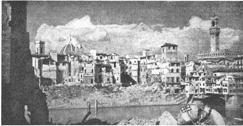
Florenz. Die Zerstörungen am Lungarno Acciaiuoli. Rechts der intakte Ponte Vecchio
