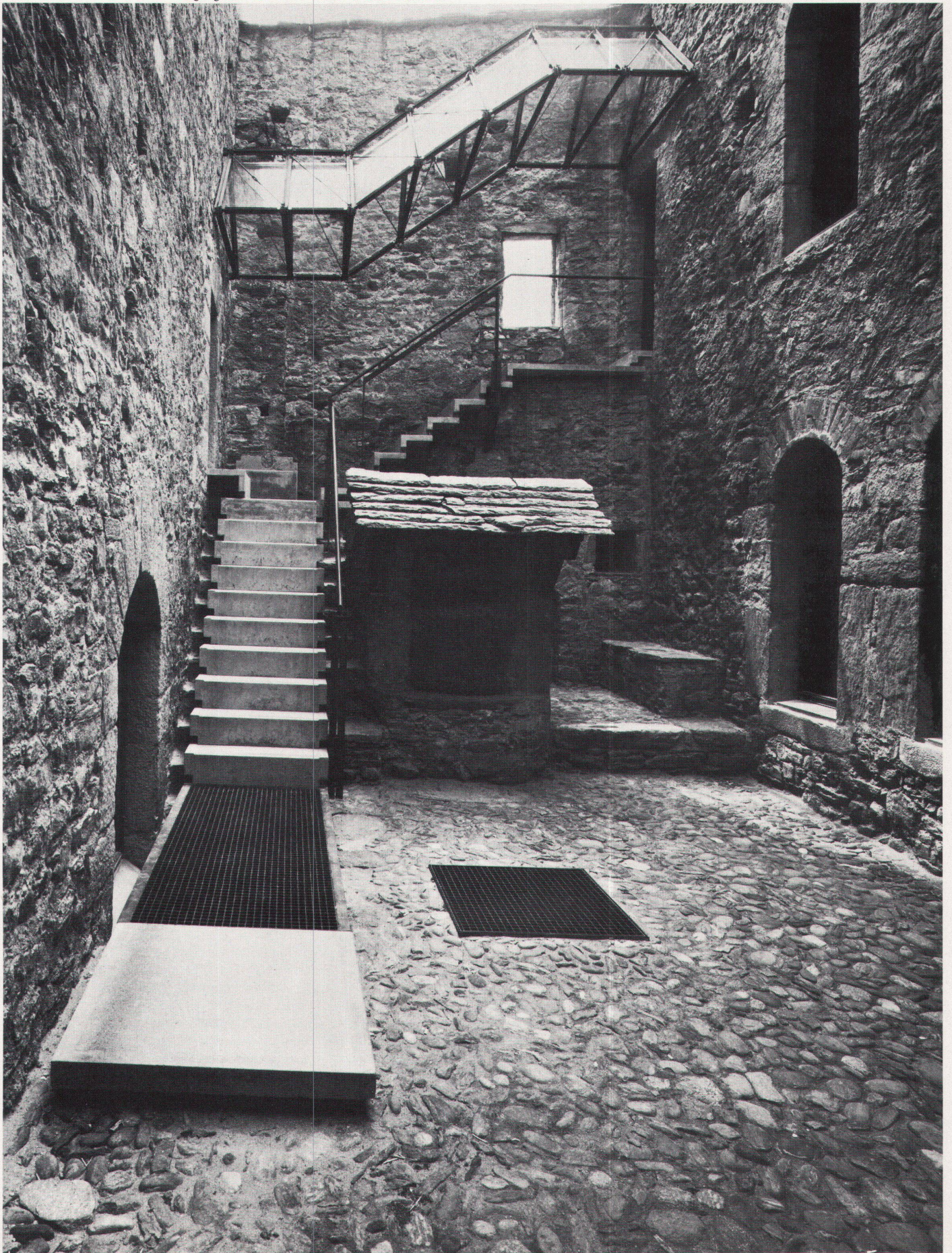
3 Innenhof mit Ziehbrunnen. Zugang zum Turm (links) und Palazzetto (rechts)
