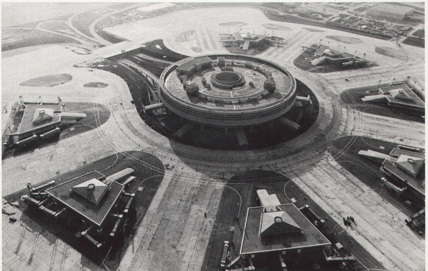
Le bâtiment central et les satellites/Das zentrale Gebäude mit den Satelliten
