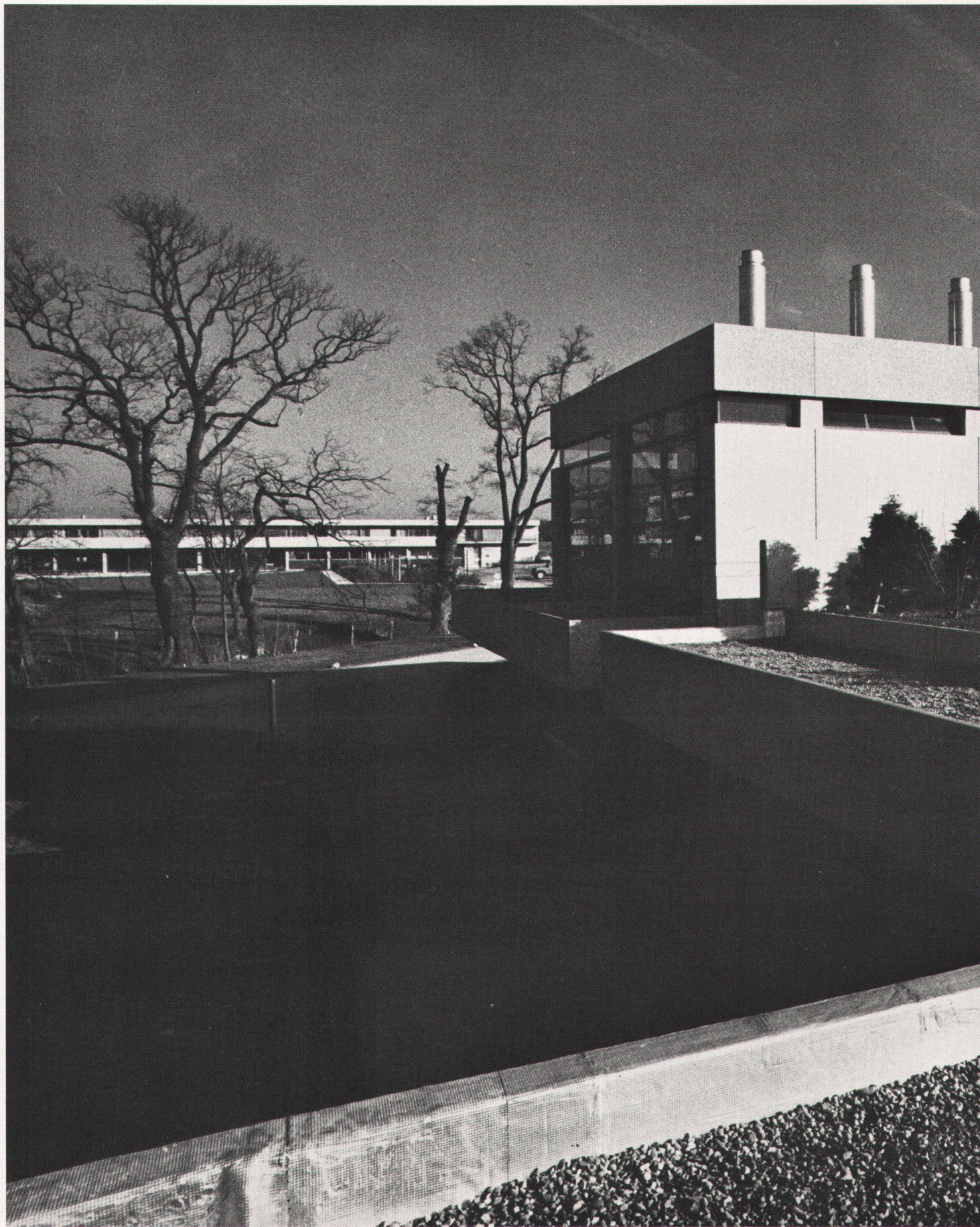
Centre de chaufferie
