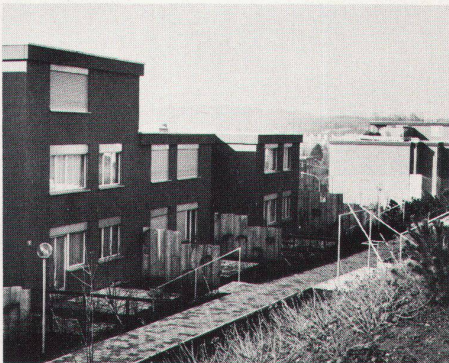
Detailaufnahmen der Überbauung 1
