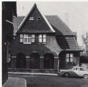
3 Beispiel eines Doppelhauses
