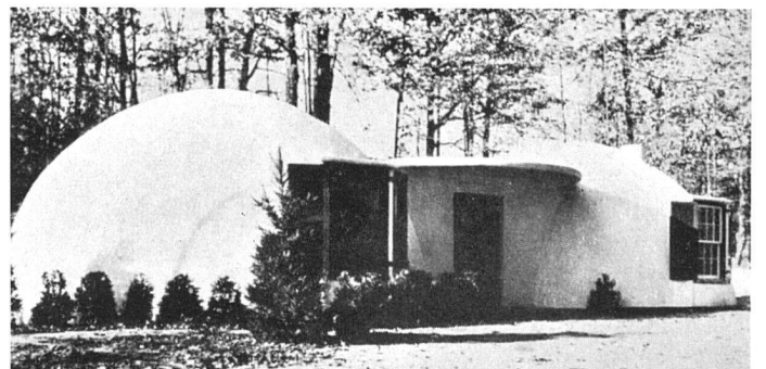
Abb. 10 Amerika. Behelfsheim in Spritzbeton mit Ballonschalung
