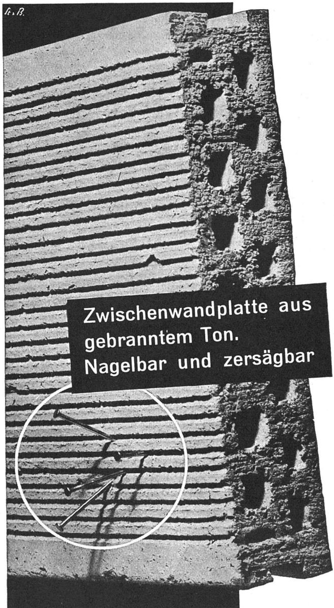
Zwischenwandplatte aus gebranntem Ton. Nagelbar und zersägbar
