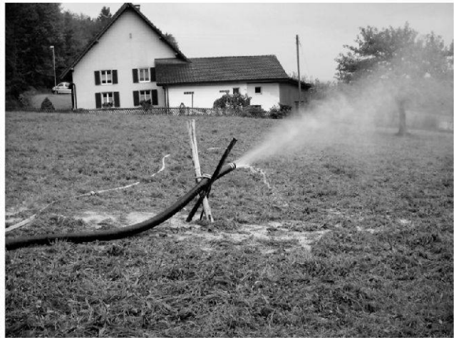
Fig. 3: Erdgasaustritt vor der kontrollierten Entzündung. Links: Ausblasen über die Absetzmulde in die Absetzmulde für Bohrklein. Rechts: Verlängerte und umgelegte Spülungsleitung auf das freie Feld.
