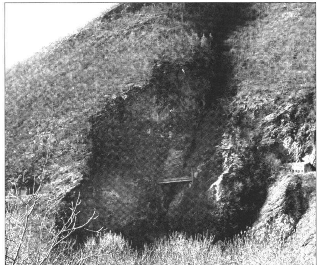
Fig. 1: Die Brücke Val d'Infern als Verbindung zweier Tunnel quert eine geologische Störzone.
