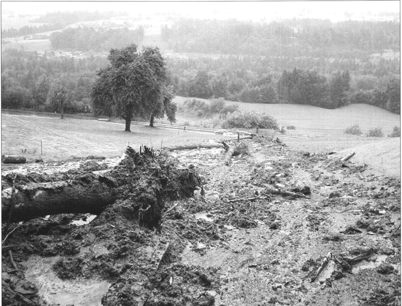
Fig. 7: Die Ansicht der Fahrböschung der aus Murgang Nr. 11 gebildeten hyperkonzentrierten Strömung verdeutlicht die nur mehr geringe Sedimentfracht. Die hohe Energie, die diese hyperkonzentrierte Strömung gehabt haben muss, lässt sich auf Grund der auf das Wiesland katapultierten Baumstämme erahnen. Im Hintergrund ist die Kantonsstrasse sichtbar.
