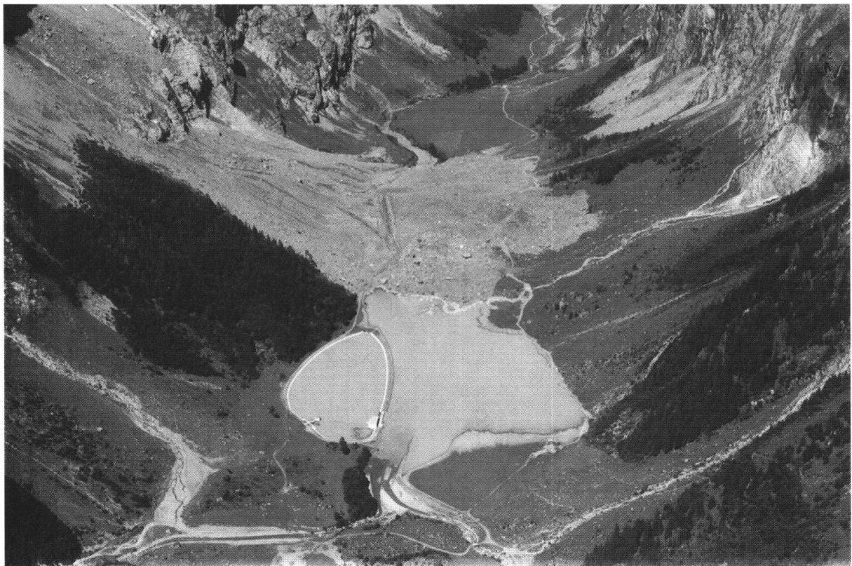
Fig. 8: Schuttkegel der Sandalpbergstürze von Westen. Seeaufstau infolge des Starkregens vom Juli 1996 (Photo Th. Rageth).
