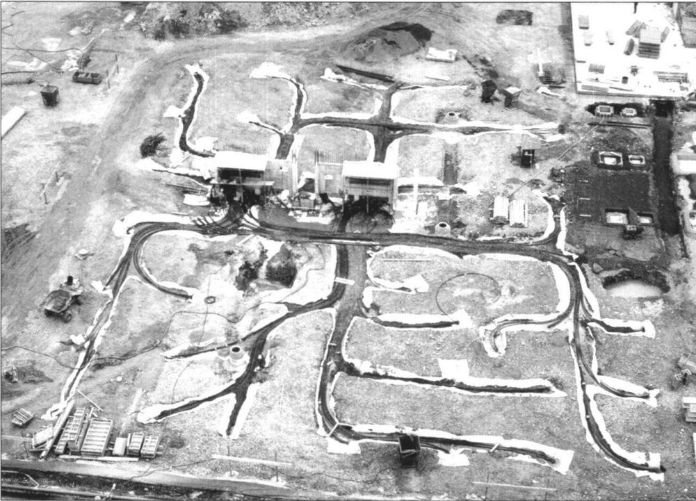
**Fig.11:** Überblick der beiden Verteiler sowie der im Sandbett verlegten Sondenzuleitungen und -ableitungen (Zustand Mitte Oktober 2001).
