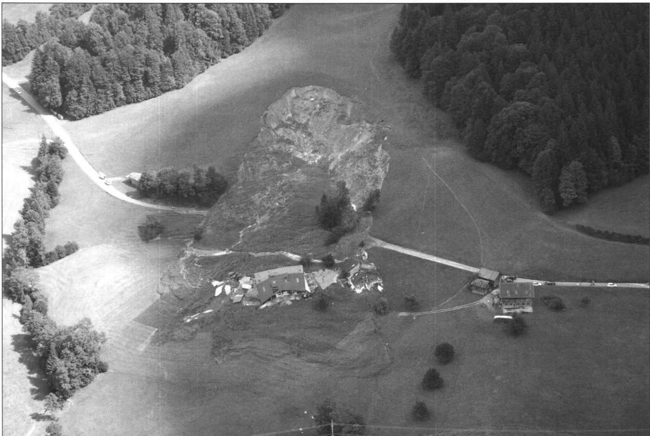
Fig. 2: Die Rutschung Feldweid. Situation am 23. August 2005 (Foto Schweizer Luftwaffe). Die Rutschung zerstörte die Scheune und das Wohnhaus der Liegenschaft Feldweid, die Renggstrasse wurde talwärts geschoben. 2006 brach eine weitere Rutschscholle ab. Sie riss im Wald, seitlich zur Anbruchnische von 2005, rechts oben im Bild, ab.
