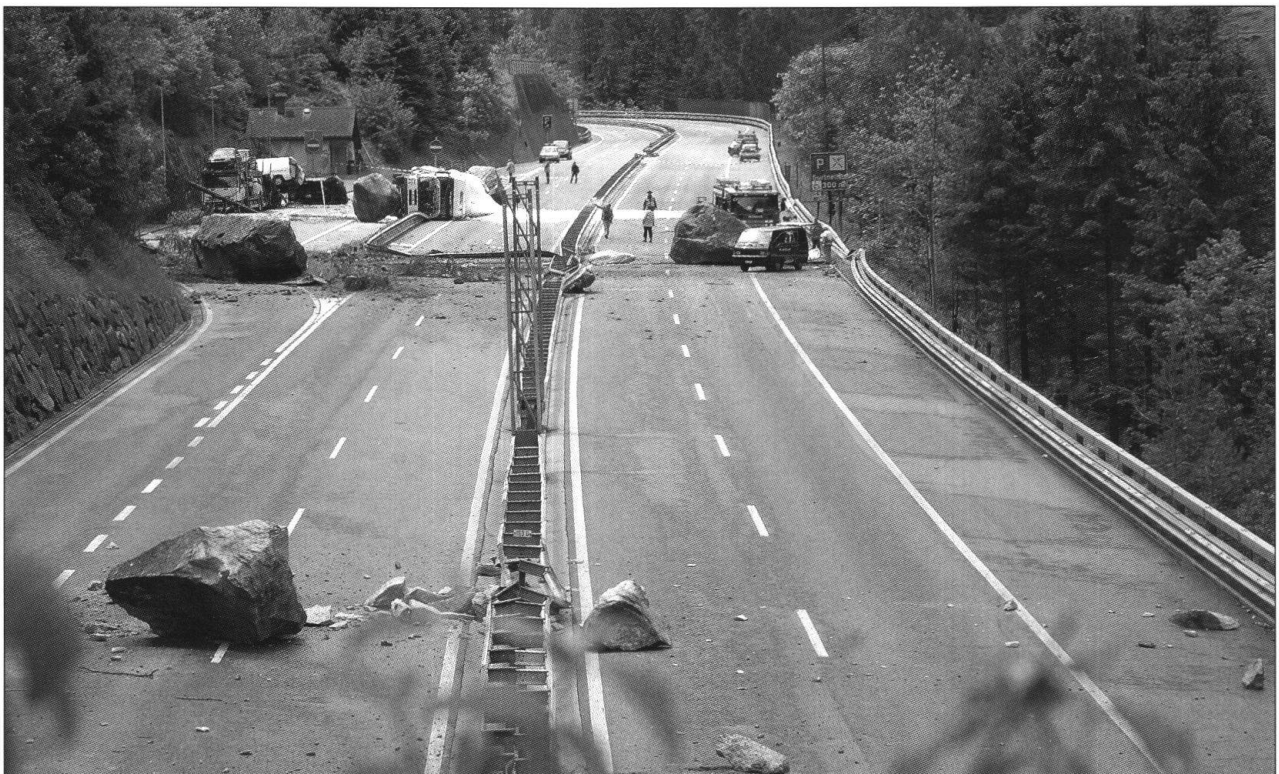
Fig. 9: Felssturz Gurnellen, 31. Mai 2006 (Foto Kantonspolizei Uri). Grossblöcke mit Kubaturen zwischen 6 und 60 m 3 erreichten die Autobahn oder stürzten sogar noch über diese hinaus. Daneben lagen viele Splitterblöcke auf der Fahrbahn.
