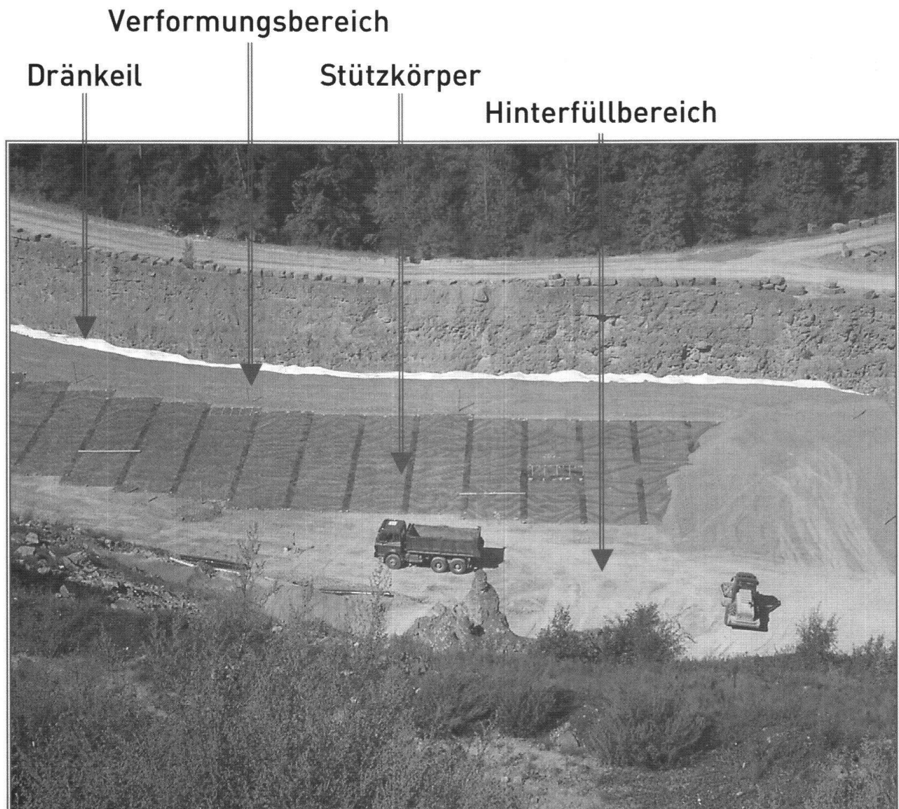
Fig. 4: Das teilweise aufgefüllte Abbaufeld während den Einbauarbeiten.
