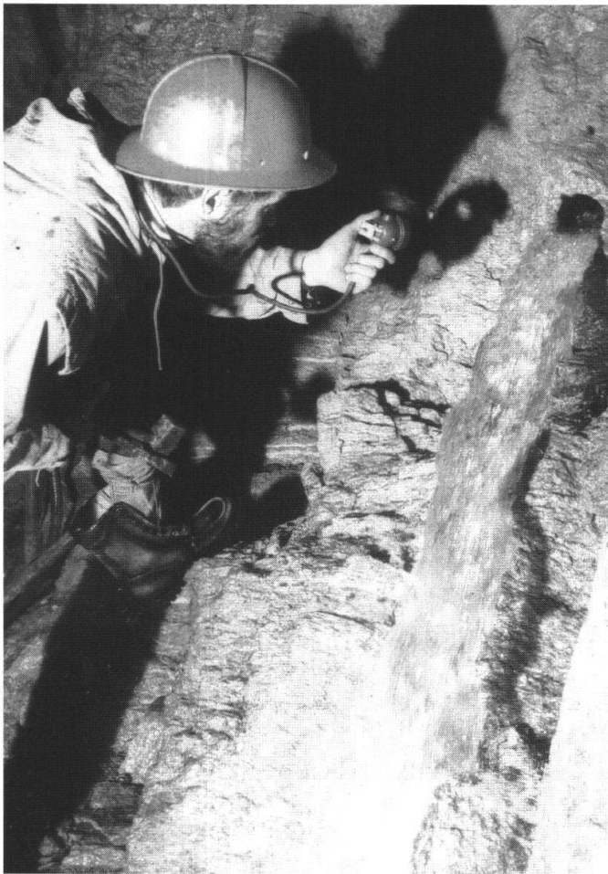
Fig. 9: Trinkwasserbohrung vom Stollen aus (ca. 5.5 l/s).
