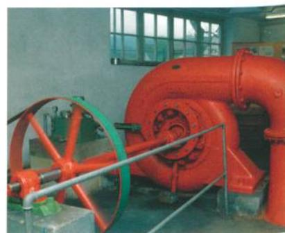
Abb. 2: Die Turbine aus dem Jahre 1862 wird vom Wasser der Luterer angetrieben und produziert heute jährlich rund 80'000 Kilowattstunden elektrische Energie
