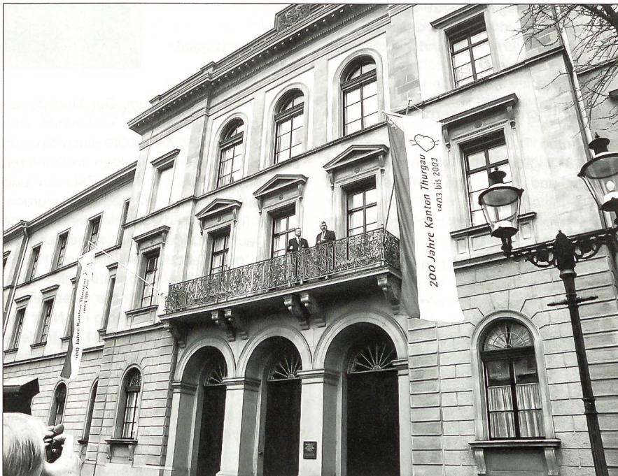
Die Fahnen am Regierungsgebäude in Frauenfeld.
