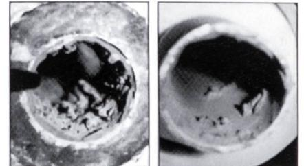
Links: Kalkablagerungen in einem Eisenrohr mit korrodiertem Eisenanteil. Rechts: Dieselbe Leitung nach nur 3monatigem Einsatz eines RoKa-Tech-Kalk- und Rostschutz-Gerätes.
