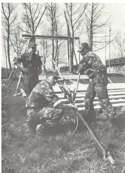
Spannen der Verankerung mit dem Seilzugapparat
