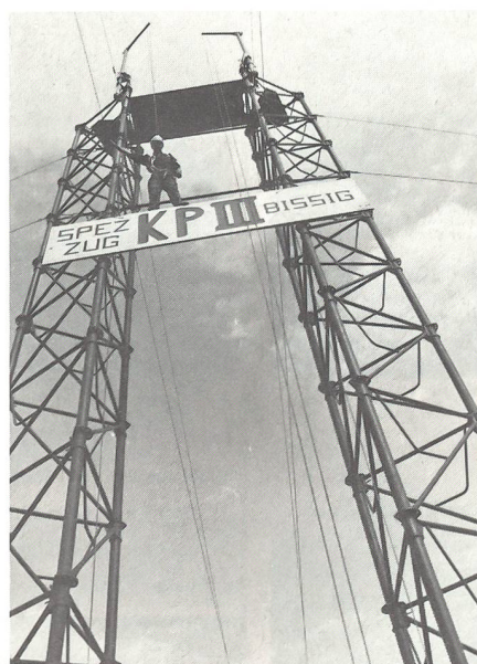
In luftiger Höhe: Stütze zur Festen Brücke 69
