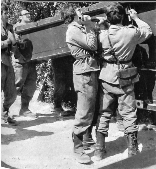
Brückenecke: Die Rampe am Einbauufer wird erstellt.
