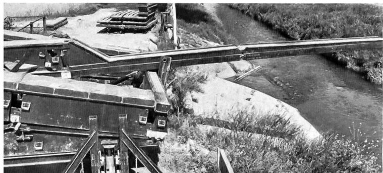
Brückeneinde: Die Rampe am Einbauufer wird angeschlossen.
