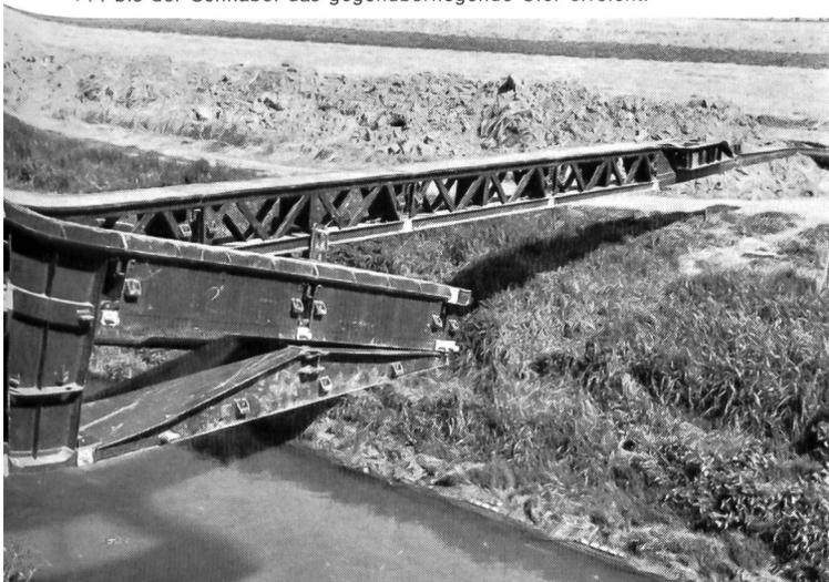
Die Brücke befindet sich am gegenüberliegenden Ufer. Der Schnabel wird abgebaut.
