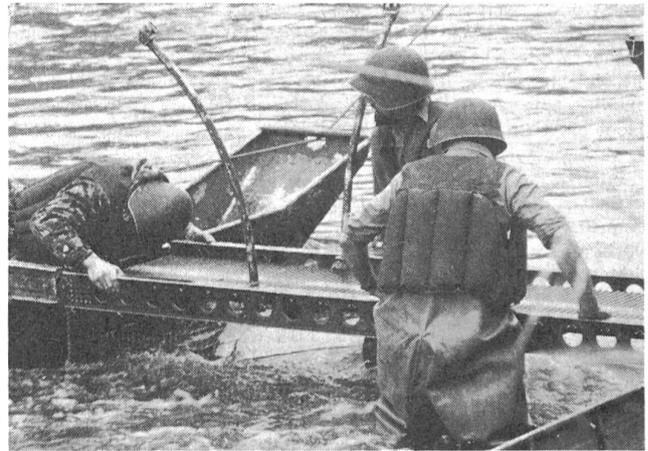
Die Elemente werden rasch zusammengesoben. Die strengste Arbeit leistet der auf dem Bauche liegende Kopplungsmann.
