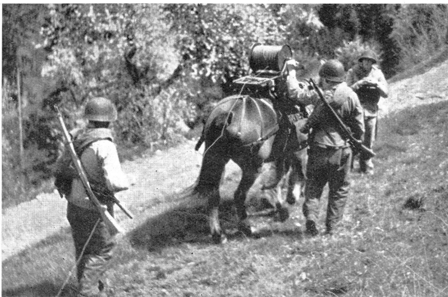
Das verlegte Kabel wird wieder eingezogen.
