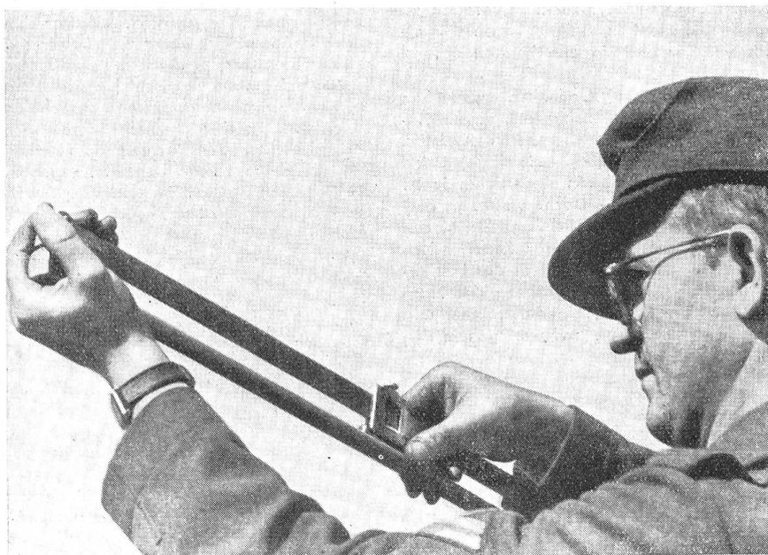
Mit einer Spezial-Schublehre wird der Abstand zwischen den beiden Kerben auf dem größtem Fallgewicht gemessen: eine einfache Formel ergibt dann die Anfangsgeschwindigkeit des Geschosses.
