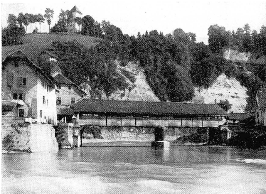
Fig. 2. Pont de Berne, vue aval
