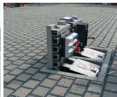
Unterflurelektranten
