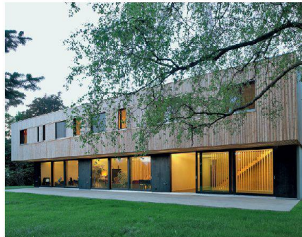
01 Nach Südwesten, zum Gemeinschaftsgarten hin, erscheint das Mehrfamilienhaus als einheitliches Volumen
