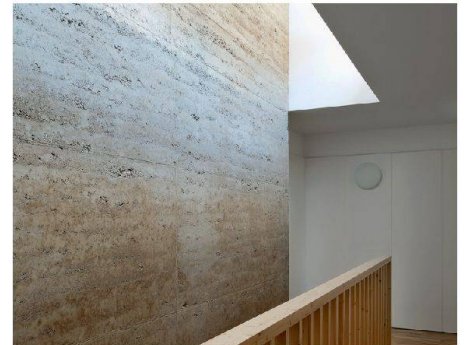
02 Das Material für die Stampflehmwände stammt aus dem Kelleraushub (Fotos: Thomas Jantscher)
