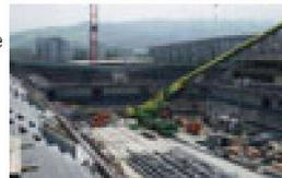
Bild 1: Versetzen der Elemente mit Autokran
