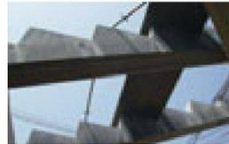
Bild 3: Tribünentragkonstruktion: Die Sägezahnträger
